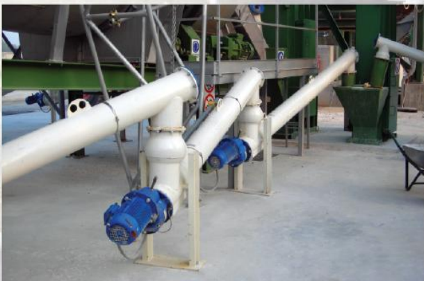
8.4 Lắp đặt vít tải D219 L5m Nhà máy vôi Hoàn Bồ
